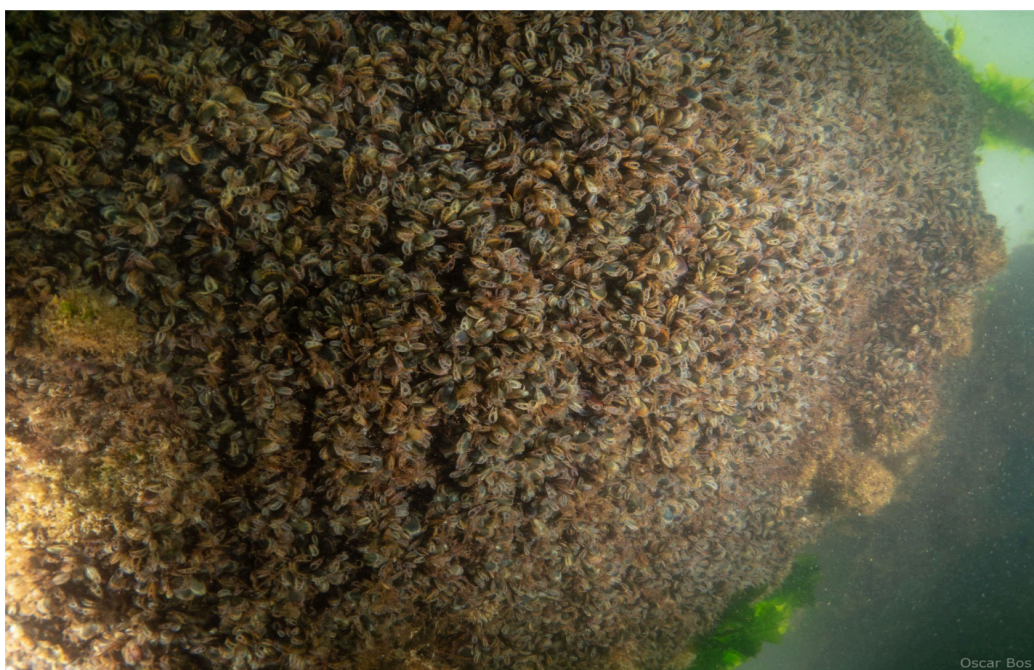
Figuur 3.1 Aangroei op een structuur van zonnepanelen op zee (point absorber, drijvend). Mavraki et al. (2023)
