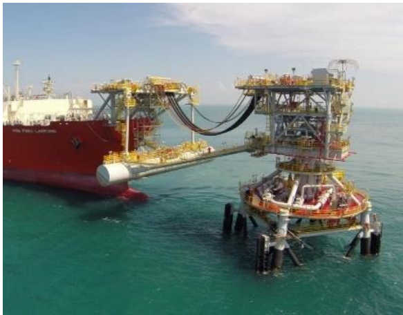
Figuur 5-3: Voorbeeld complexe turret tower met yoke
