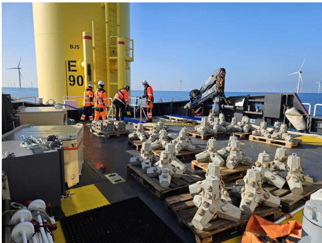
Afbeelding 4.6 Droppable oyster structures (DOS) op het dek vlak voor installatie in Borssele I & II. Bron: Toolbox De Rijke Noordzee
